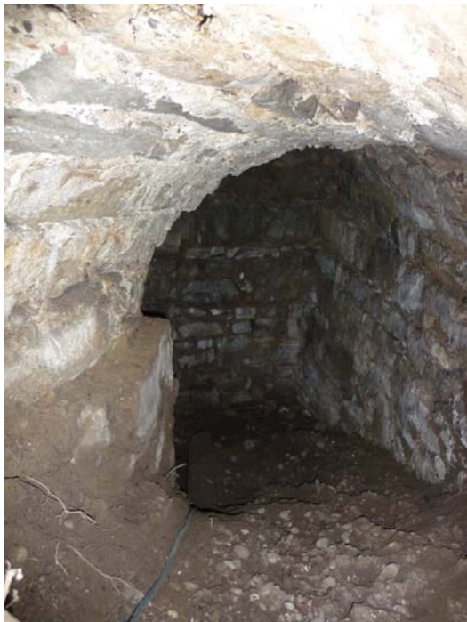
La galerie d'accès. L'entrée dans la glacière se trouve à gauche au fond de ce couloir.
